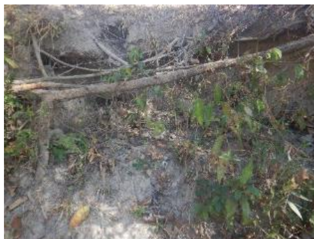
Foto 320 – Detalhe do corte com exposição de solo siltoso de coloração cinza.
