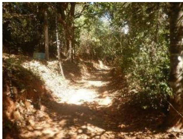
Foto 134 – Corte em estrada com solo marrom siltoso.
