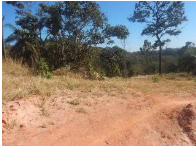
Foto 289 – Vista geral da área cortada pelo empreendimento com exposição de solo siltoso de coloração marrom -avermelhada e processos erosivos.
