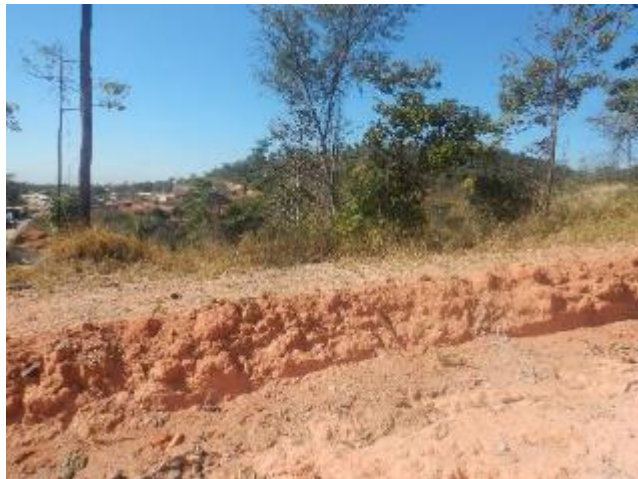
Foto 291 - Vista geral da área cortada pelo empreendimento com exposição de solo siltoso de coloração marrom -avermelhada e processos erosivos.
