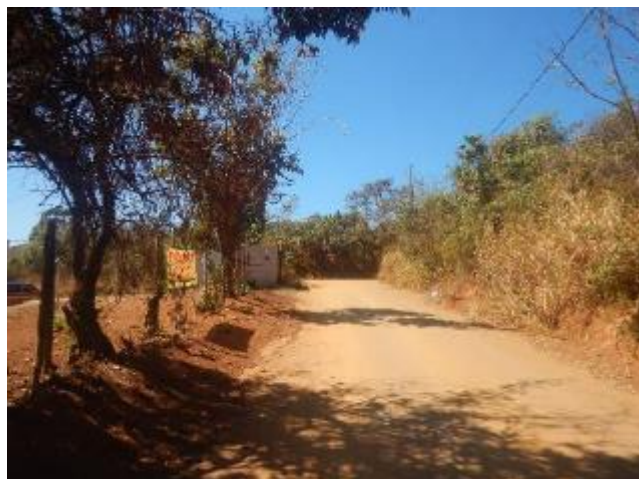
Foto 353 – Vista geral da área cortada pelo empreendimento, em área urbana.
