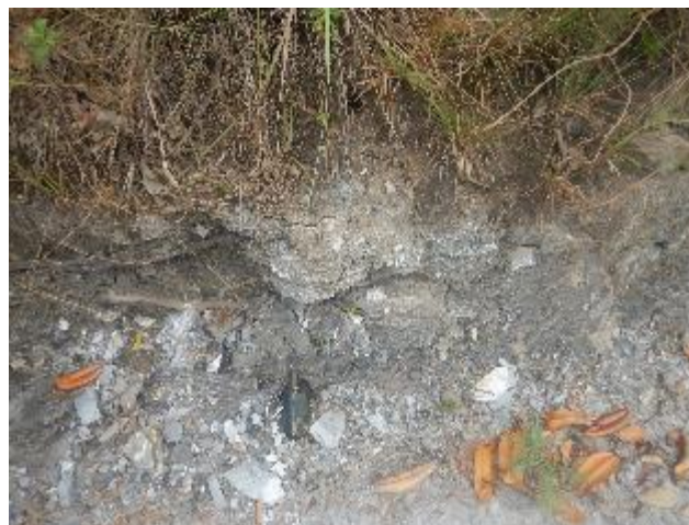
Foto 406 – Vista geral da área cortada pelo empreendimento com afloramento de rocha metamórfica e acamamento subvertical.
