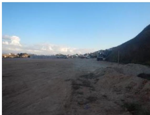
Foto 224 – Vista geral da área cortada pelo empreendimento, com terraplanagem.
