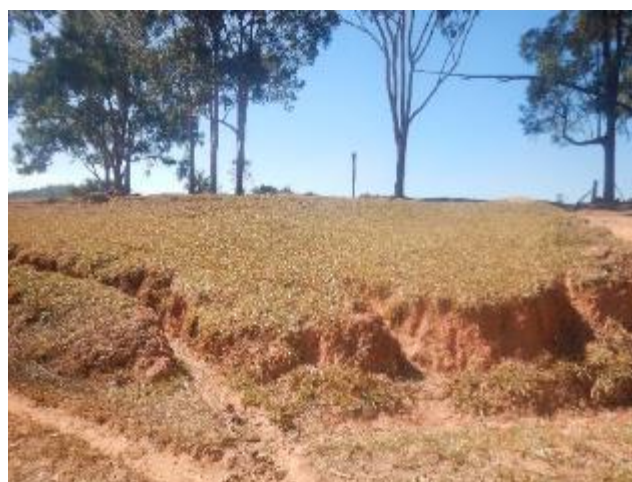
Foto 300 – Vista geral da área cortada pelo empreendimento com exposição de solo siltoso de coloração marrom -avermelhada e pastagem.
