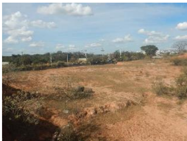
Foto 259 - Vista geral da área cortada pelo empreendimento com exposição de solo siltoso de coloração marrom -avermelhada e processos erosivos.
