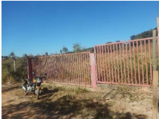
Foto 185 – Área de um galpão em construção.
