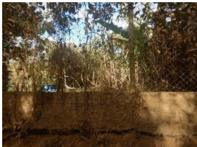
Foto 81 – Edificação cortada pelo empreendimento.
