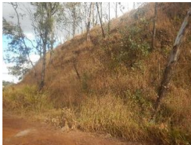
Foto 58 – Vista geral da área cortada pelo empreendimento, com afloramento de formação ferrífera bandada.
