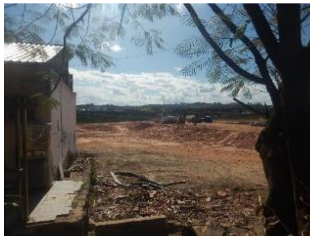
Foto 188 – Área de um galpão em construção com movimentação de solo.
