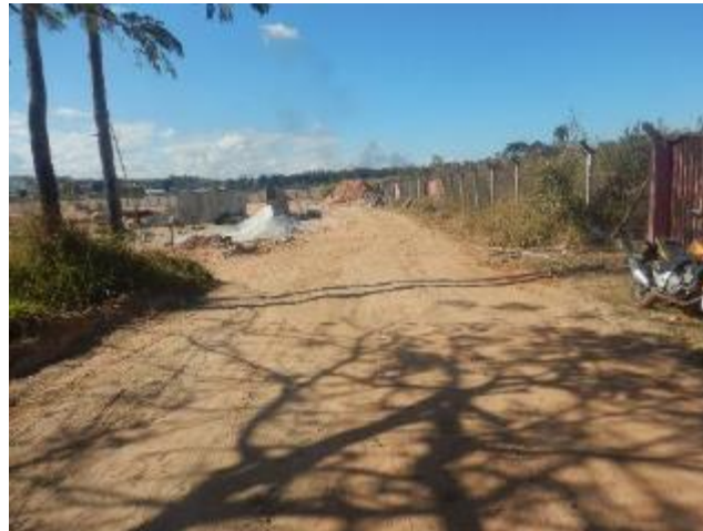
Foto 186 – Área de um galpão em construção.
