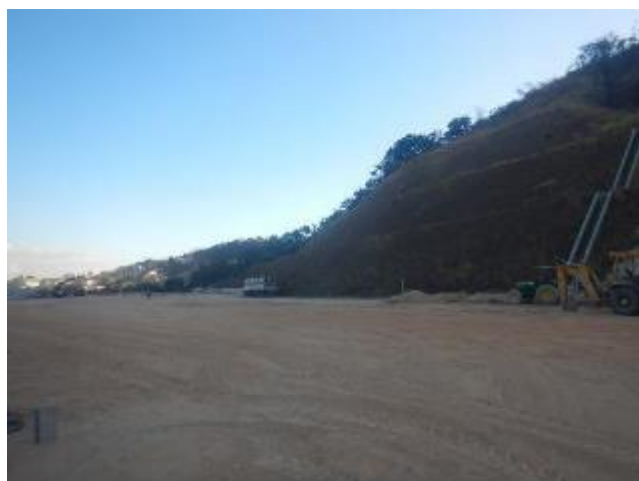
Foto 223 - Vista geral da área cortada pelo empreendimento, com terraplanagem.
