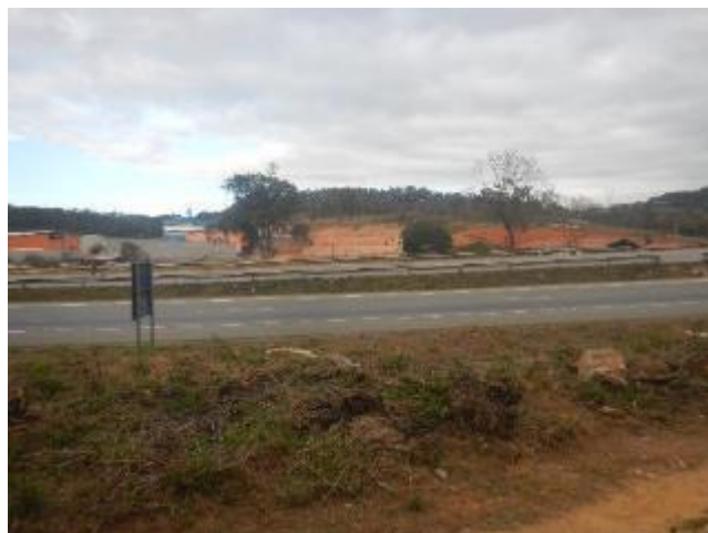
Foto 6.5-1 – Vista geral da área cortada pelo empreendimento, com corte em solo ao fundo.
