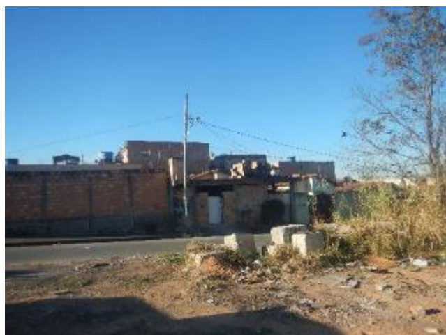
Foto 215 - Vista geral da área cortada pelo empreendimento, em área urbana.
