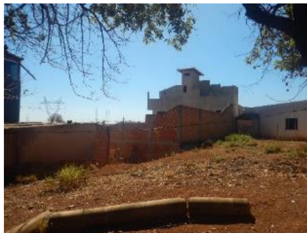
Foto 354 – Vista geral da área cortada pelo empreendimento, em área urbana.
