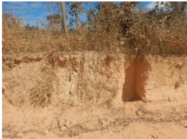
Foto 109 – Corte de estrada com quartzito fino alterado.
