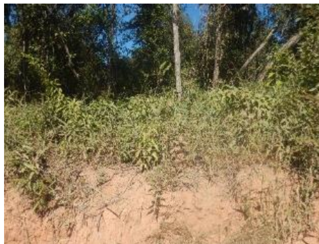
Foto 296 – Vista geral da área cortada pelo empreendimento com exposição de solo siltoso de coloração marrom -avermelhada e pastagem.
