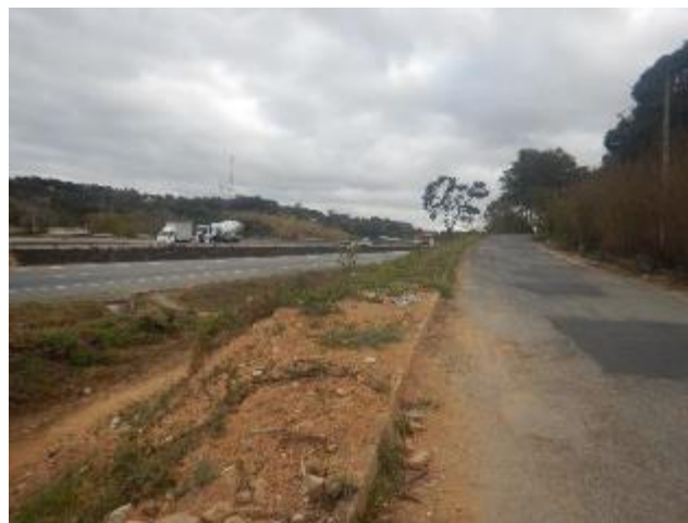
Foto 6.5-2 – Vista geral da área cortada pelo empreendimento.
