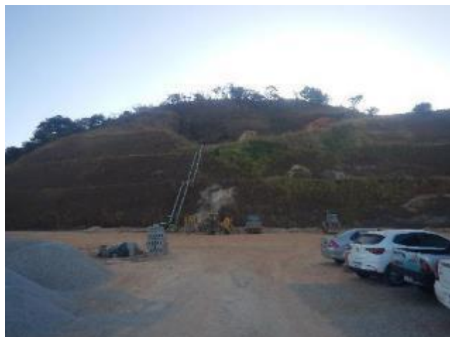
Foto 221 – Vista geral da área cortada pelo empreendimento, com terraplanagem.
