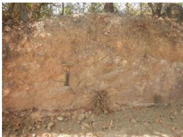
Foto 167 – Exposição de solo residual com rocha alterada.
