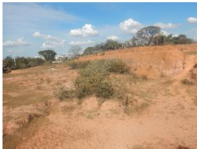
Foto 258 – Vista geral da área cortada pelo empreendimento com exposição de solo siltoso de coloração marrom -avermelhada e processos erosivos.
