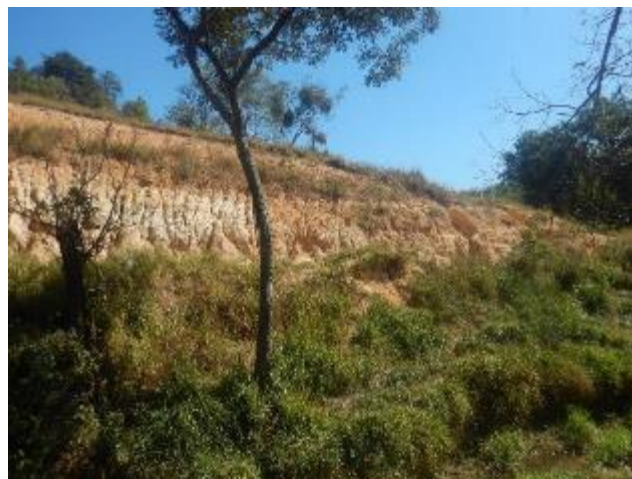
Foto 314 – Vista geral da área cortada pelo empreendimento com exposição de solo siltoso de coloração creme - avermelhado.
