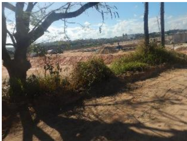
Foto 187 - Área de um galpão em construção com movimentação de solo.
