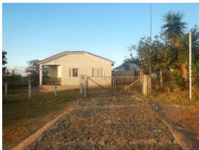
Foto 71 – Edificação dentro da área cortada pelo empreendimento.
