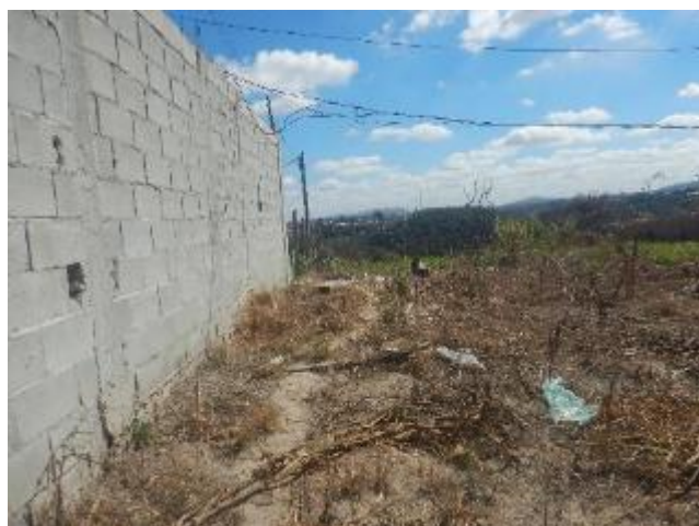
Foto 171 - Vista geral da área cortada pelo empreendimento em área urbana.
