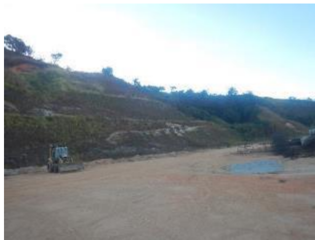
Foto 222 – Vista geral da área cortada pelo empreendimento, com terraplanagem.
