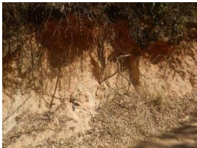
Foto 311 - Detalhe do corte com exposição de solo siltoso de coloração creme - avermelhado.
