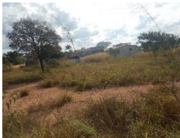
Foto 260 – Vista geral da área cortada pelo empreendimento com exposição de solo siltoso de coloração marrom -avermelhada e processos erosivos.
