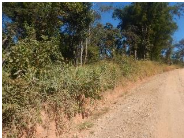
Foto 295 - Vista geral da área cortada pelo empreendimento com exposição de solo siltoso de coloração marrom -avermelhada e pastagem.
