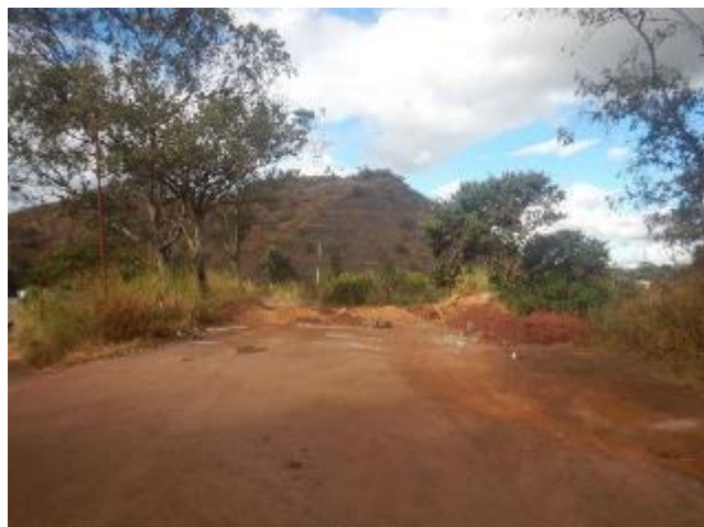
Foto 57 – Vista geral da área cortada pelo empreendimento, com relevo forte ondulado.
