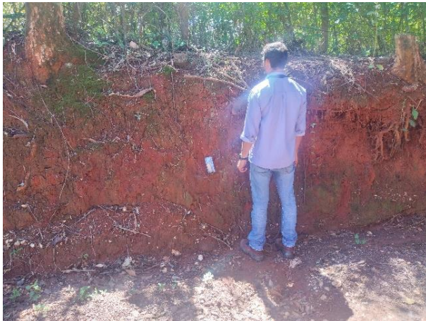
Figura 10.7-4 – Perfil de Argissolo Vermelho de textura granular, cor avermelhada e granulometria siltosa a argilosa. Ponto Amostral EMF – 118.
