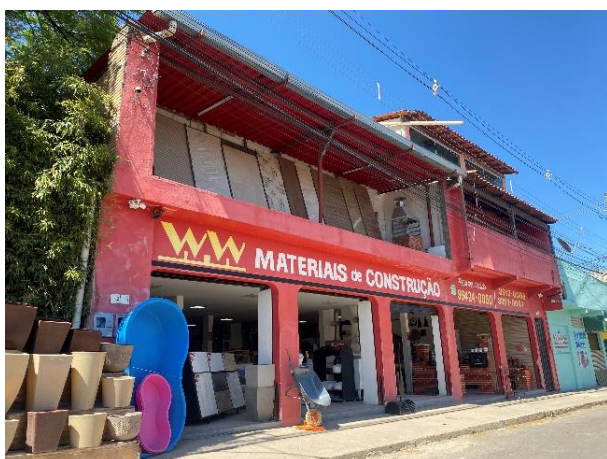
Figura 12.4-29 – Depósito de materiais de construção na AEL – Contagem.
