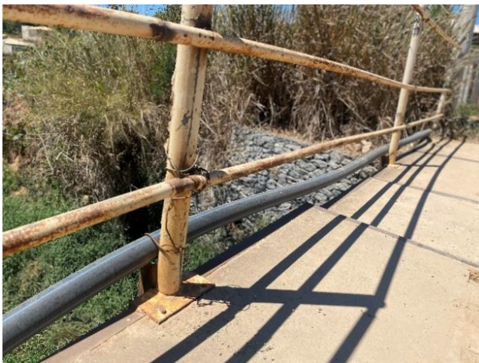
Figura 12.4-37 – Captação de água pela Copasa para abastecimento da população na AEL – Santa Luzia.
